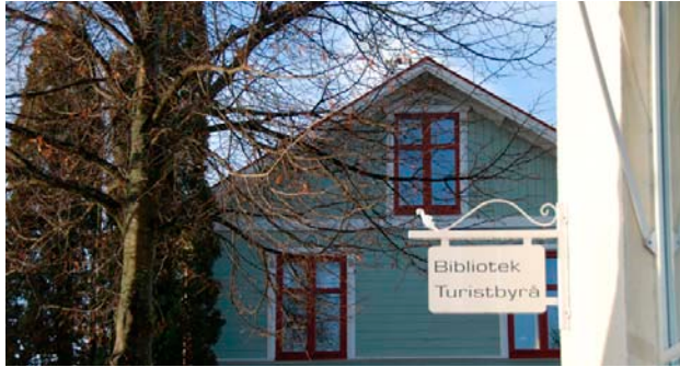
Har sadeltak med lutning 27–38 grader. Har tak som inte är högre än vägghöjden.
