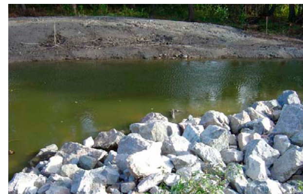
Återställningsarbeten av Trosaån efter skredet 1997.
